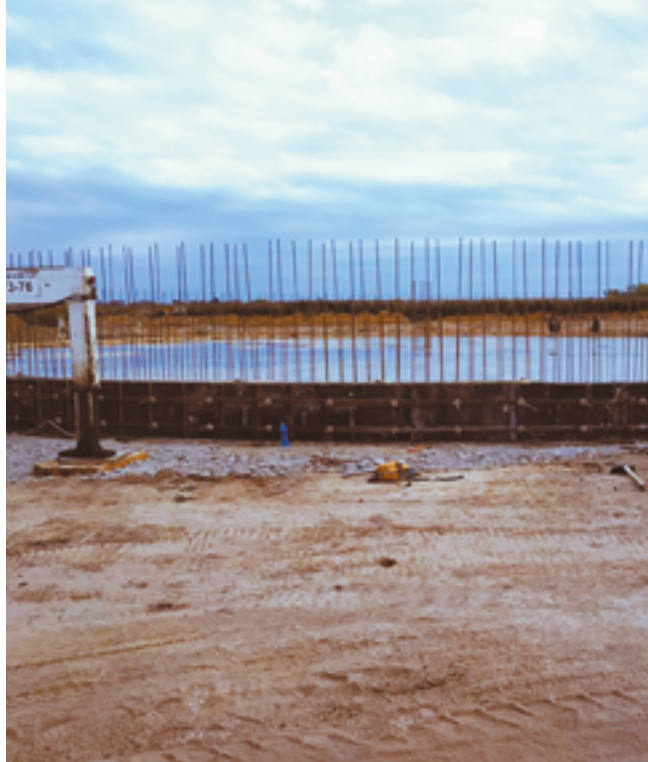
Бетонные резервуары залиты с «Пенетрон Адмиксом»
