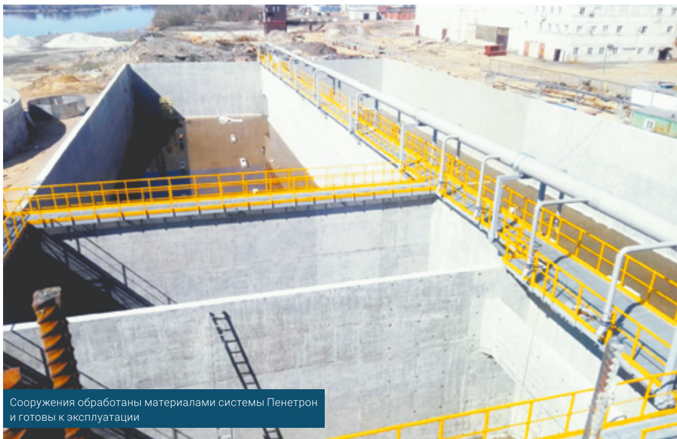
Нанесение материала «Пенетрон» на стены аэротенка
